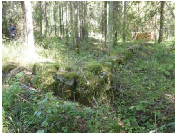
Rakennuksen 1 perustuksia, kuvattu lounaasta.
