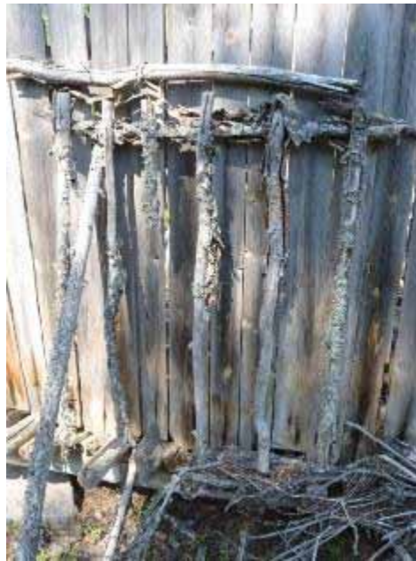
Veräjän tms. jäänteet rakennuksen seinustalla, kuvattu etelästä.
