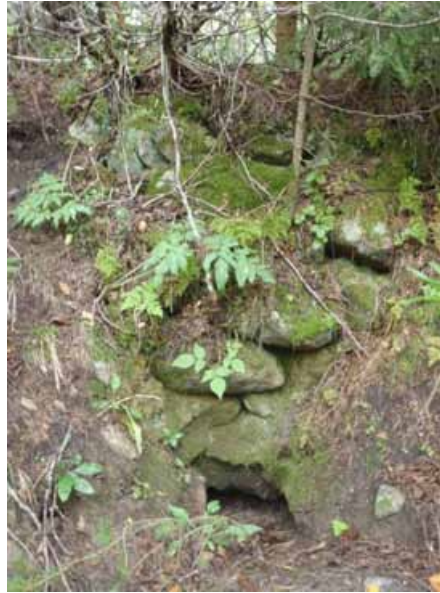
Ladottu halssirakenne vallin lounaispuolella, kuvattu lounaasta.
