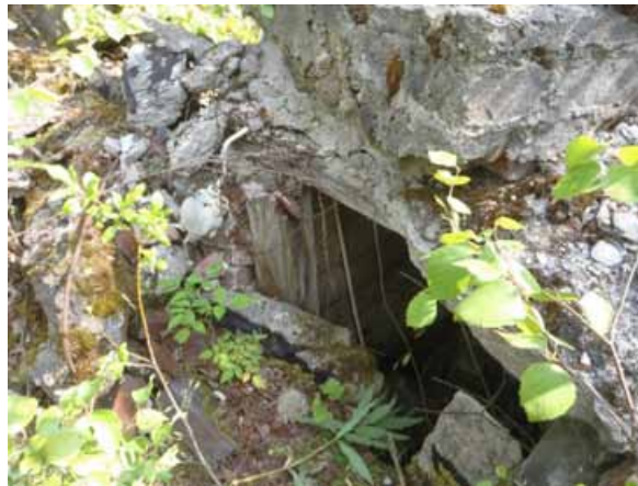
Kellarin oviaukkoa, kuvattu idästä.
