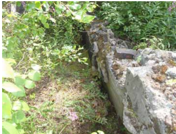
Rakennuksen betoniperustuksia, kuvattu lännestä.
