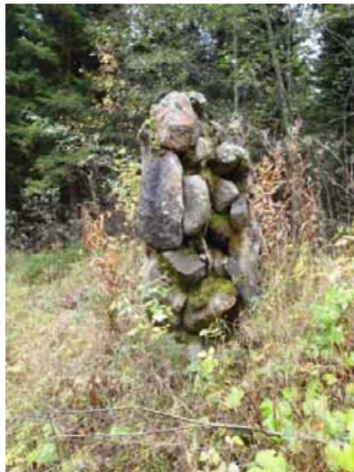
Kivi- ja betonirakenne, kuvattu lännestä.
