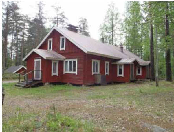
Kämppä, kuvattu koillisesta.
