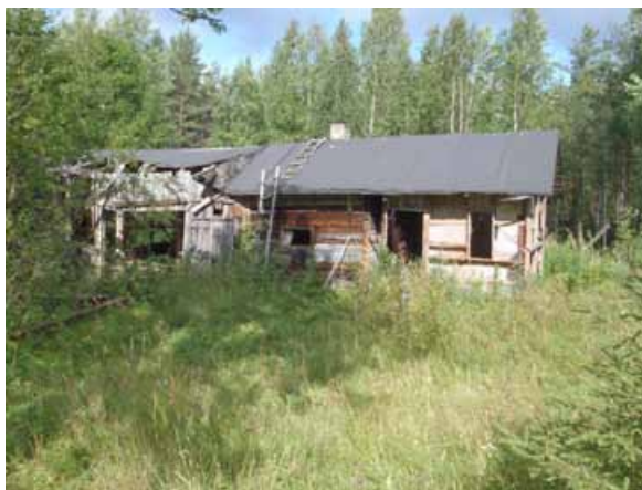
Saunarakennus, kuvattu kaakosta.
