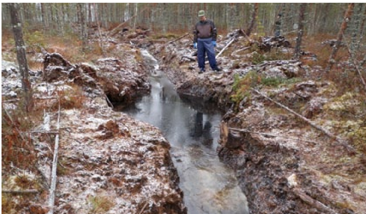
Kuva 4.1.9. Kunnostusojitusalueen sarkaojissa pidätetään lietekuopilla veden mukana, ojan pohjaa pitkin kulkeutuvaa kiintoainesta. Kuva Ari Rautio.
